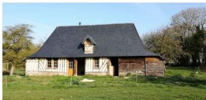
Ryc. 13: W połowie wykończony materiałami konopnymi dom w Normandii (Francja), którego pierwotną budowę określono na wczesny wiek XIX (Crini i in., 2020).
