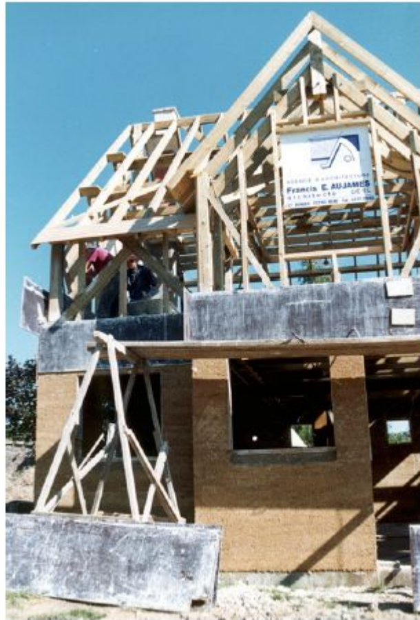
Rys 21. Domek we Francji, wykonany w całości z konopi.
