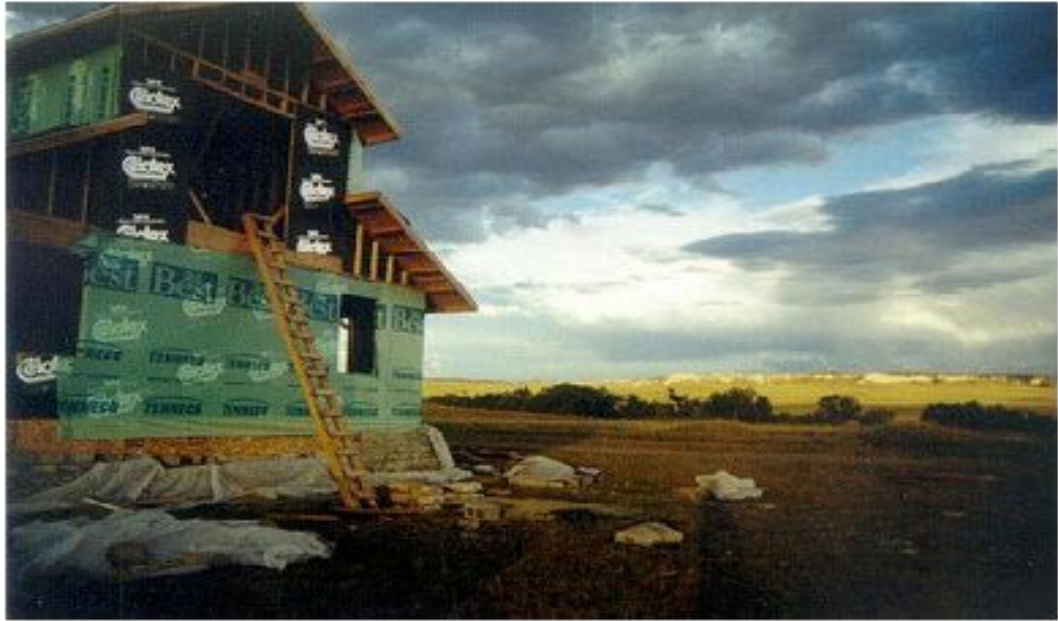
Rys 19. „Konopny domek” podczas budowy. Z konopi zrobione są takie elementy jak: bloczki fundamentowe, otynkowanie, płytki dachowe oraz izolacja.
